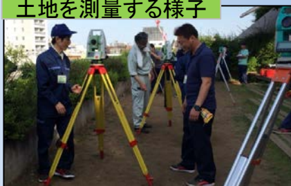
土地を測量する様子
