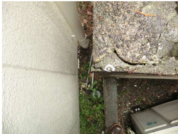
<立会予定点を白ペンキにて仮表示した事例>
