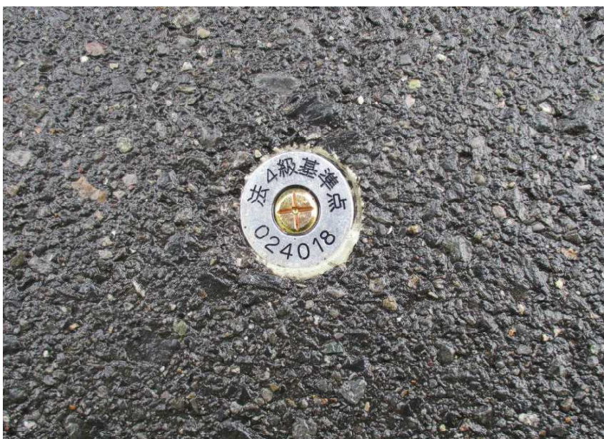
<道路地内に設置された4級基準点の例>
