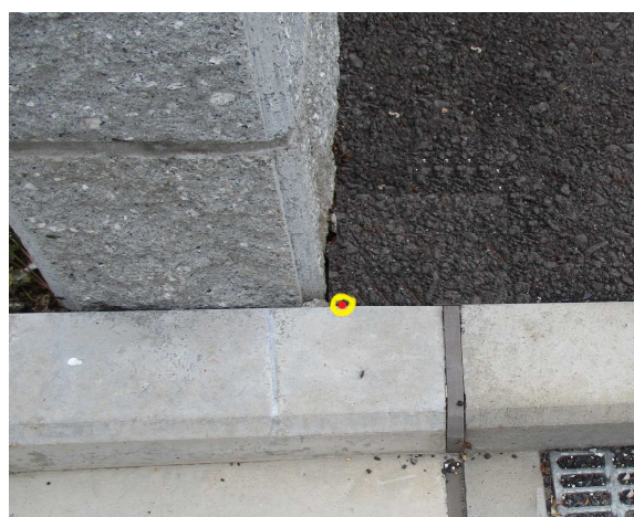
<一筆地立会済みの境界(筆界)点を赤ペンキにて表示した事例>
