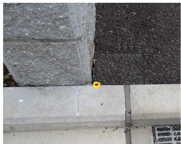
<一筆地立会済みの境界(筆界)点を赤ペンキにて表示した事例>
