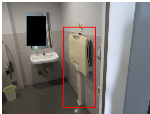
4階多目的トイレ
