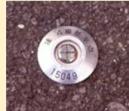
←法務局が設置する4級基準点(金属鋲)の例
