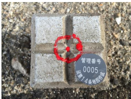
既設コンクリート杭
