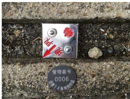
既設金属プレート
