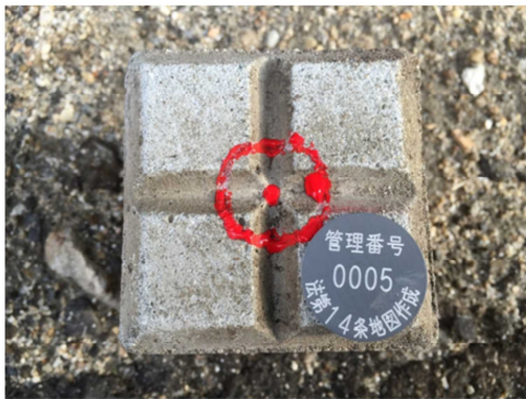
既設コンクリート杭
