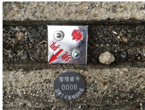
既設金属プレート
