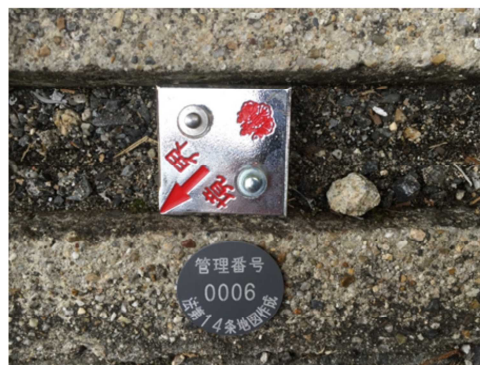
既設金属プレート
