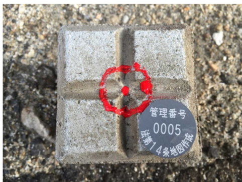
既設コンクリート杭
