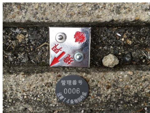
既設金属プレート
