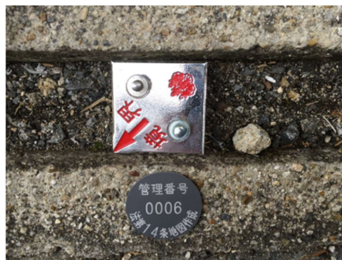
既設金属プレート
