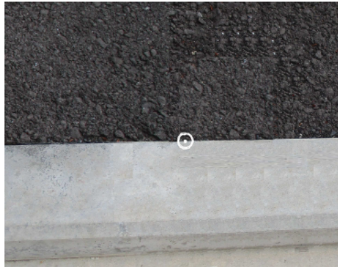
＜立会予定点を白ペンキにて仮表示した事例＞
