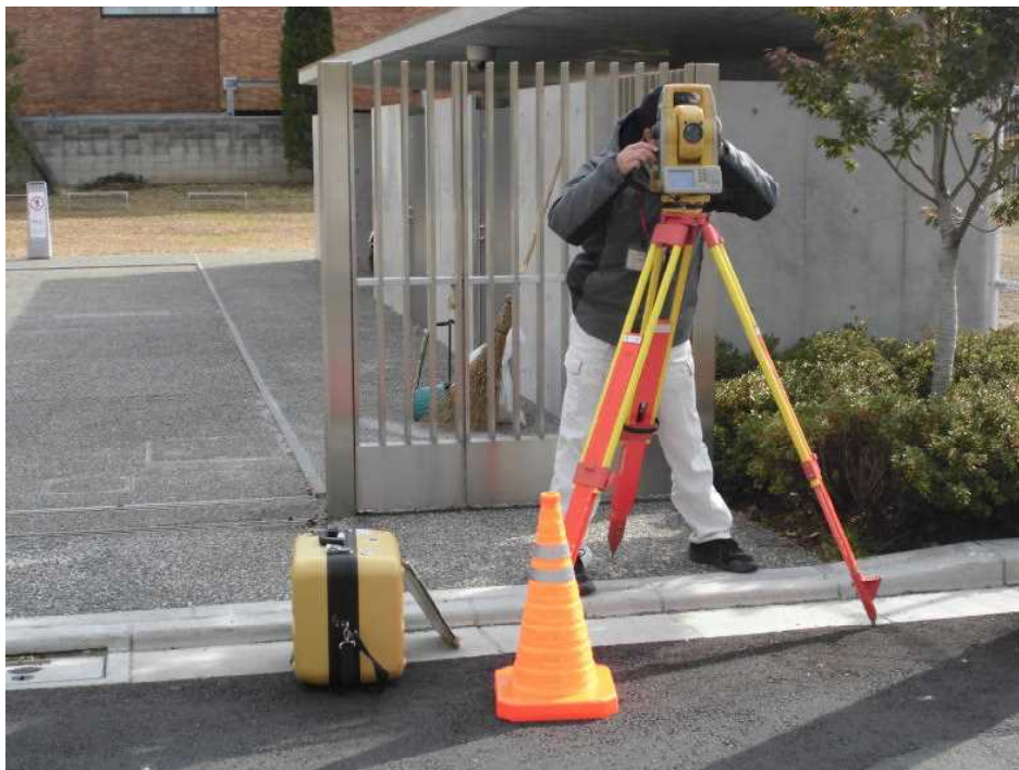
<測量作業の様子>
