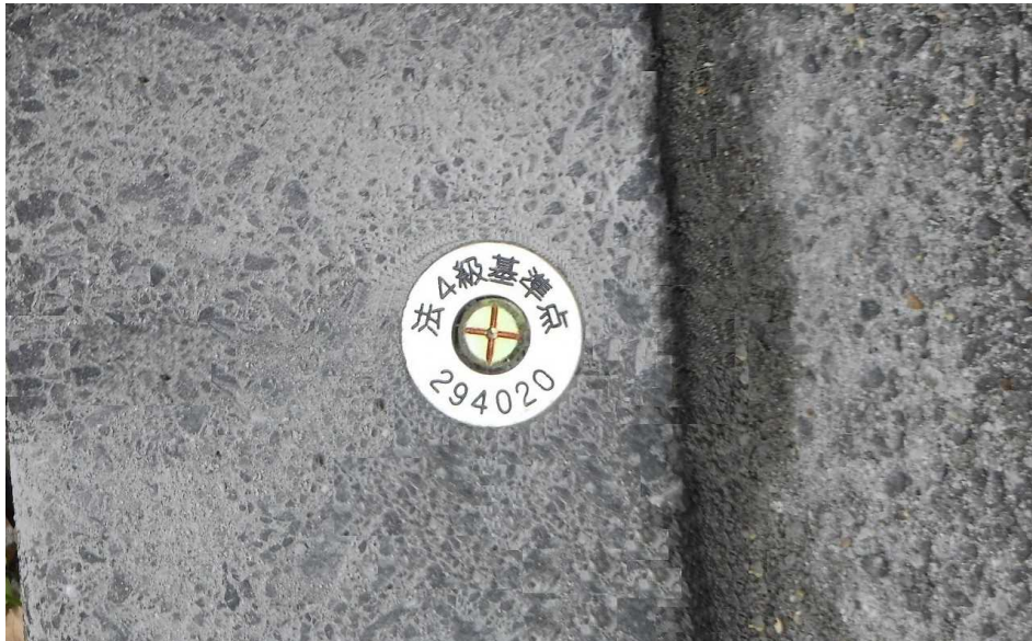
<道路地内に設置された4級基準点の例>
